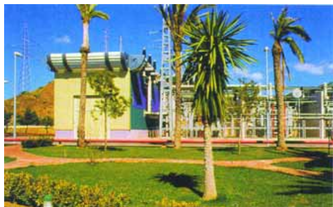
Subestació de transformació.
